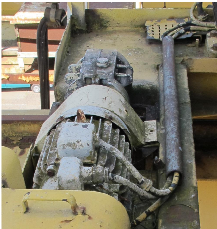
Rysunek 14. Starzenie izolacji przewodów silnika napędu jazdy suwnicy.
